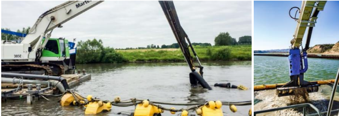
Afbeelding I.5 Een kraan voorzien van een auger unit
