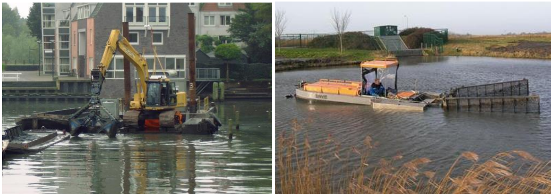
Afbeelding I.4 Mechanische verwijdering met kraan (links) of schuifboot (rechts)
