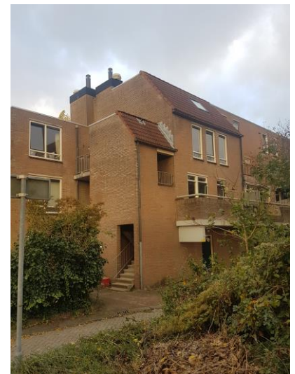
Figuur 4. Vroeger werden dit soort trappenhuisen meer toegepast in Lelystad. Tegenwoordig wordt dit type trappenhuis niet meer gebouwd.
