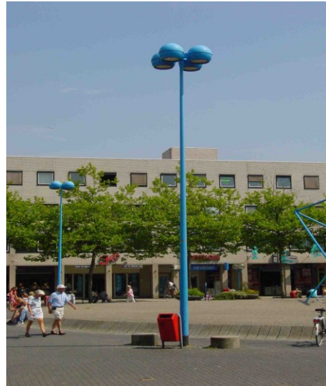
pleinverlichting met SON lamp (foto 20)
