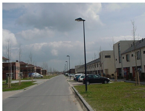
ontsluitingsweg Landstrekenwijk lichtnivo voldoende (foto 14)
