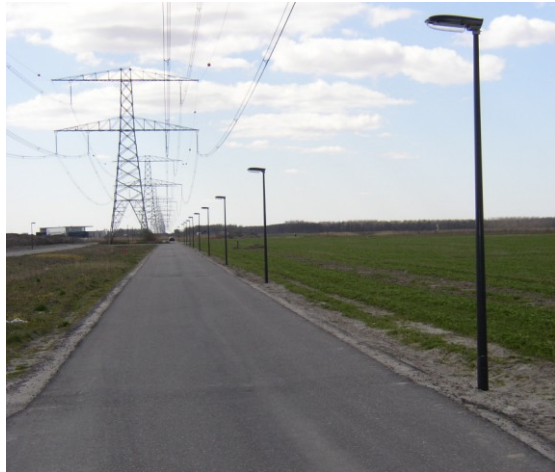
Flevopoort cluster 1 en 2 (foto 11) hoogte mast 4 meter ivm hoogspanningsmasten
