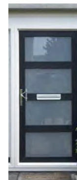
links en midden: vervanging gevelelementen. rechts: diversiteit in voordeuren.
