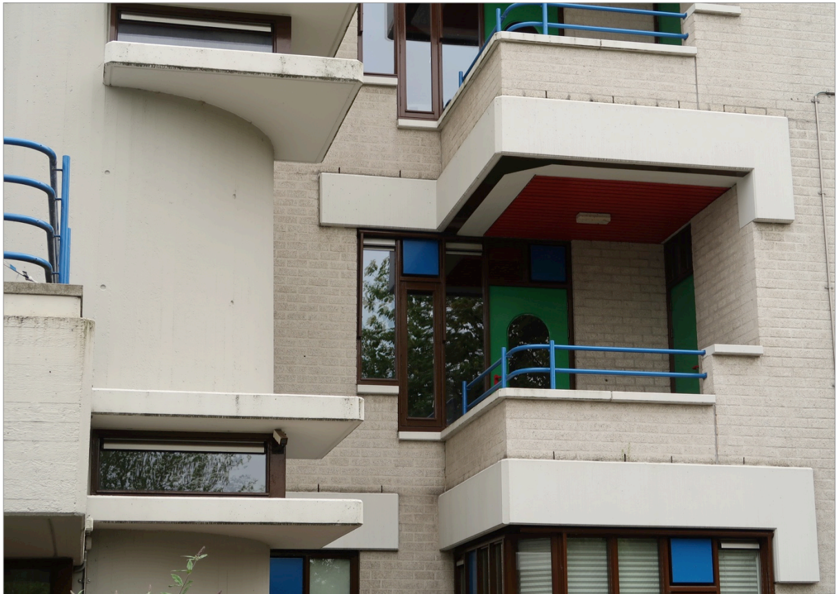
Plasticiteit van de gevel: terras en traptoren met kijkspleten (links) en inpandige balkons (rechts).
