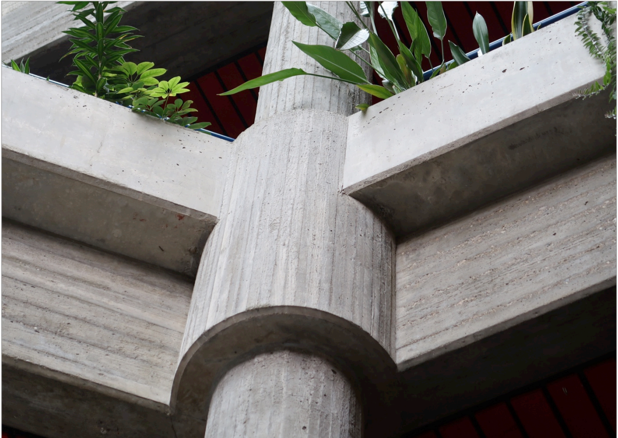
Detail: voor de afwerking van de betonconstructie zijn verschillende bekistingen gebruikt.
