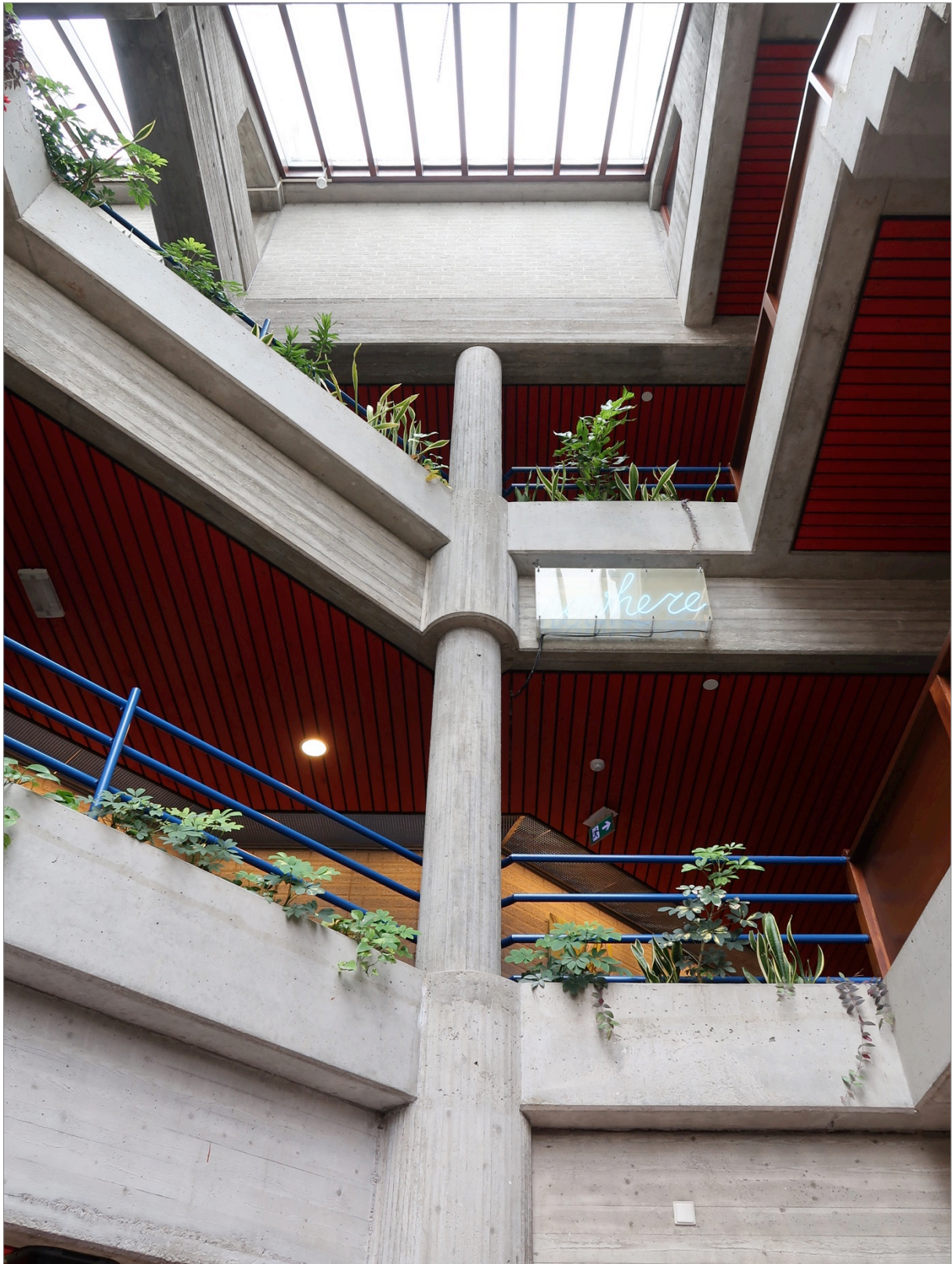
Vide: overzicht in de hoogte.
