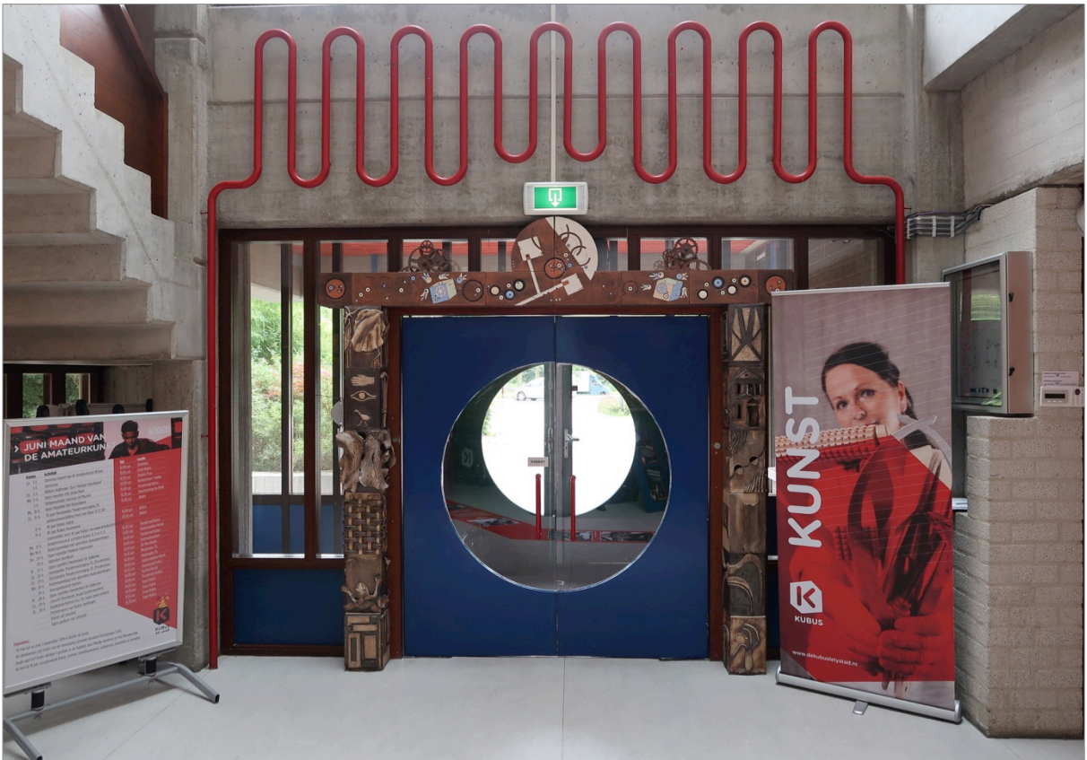
Detail: spiraalvormig verwarmingselement boven de entree.
